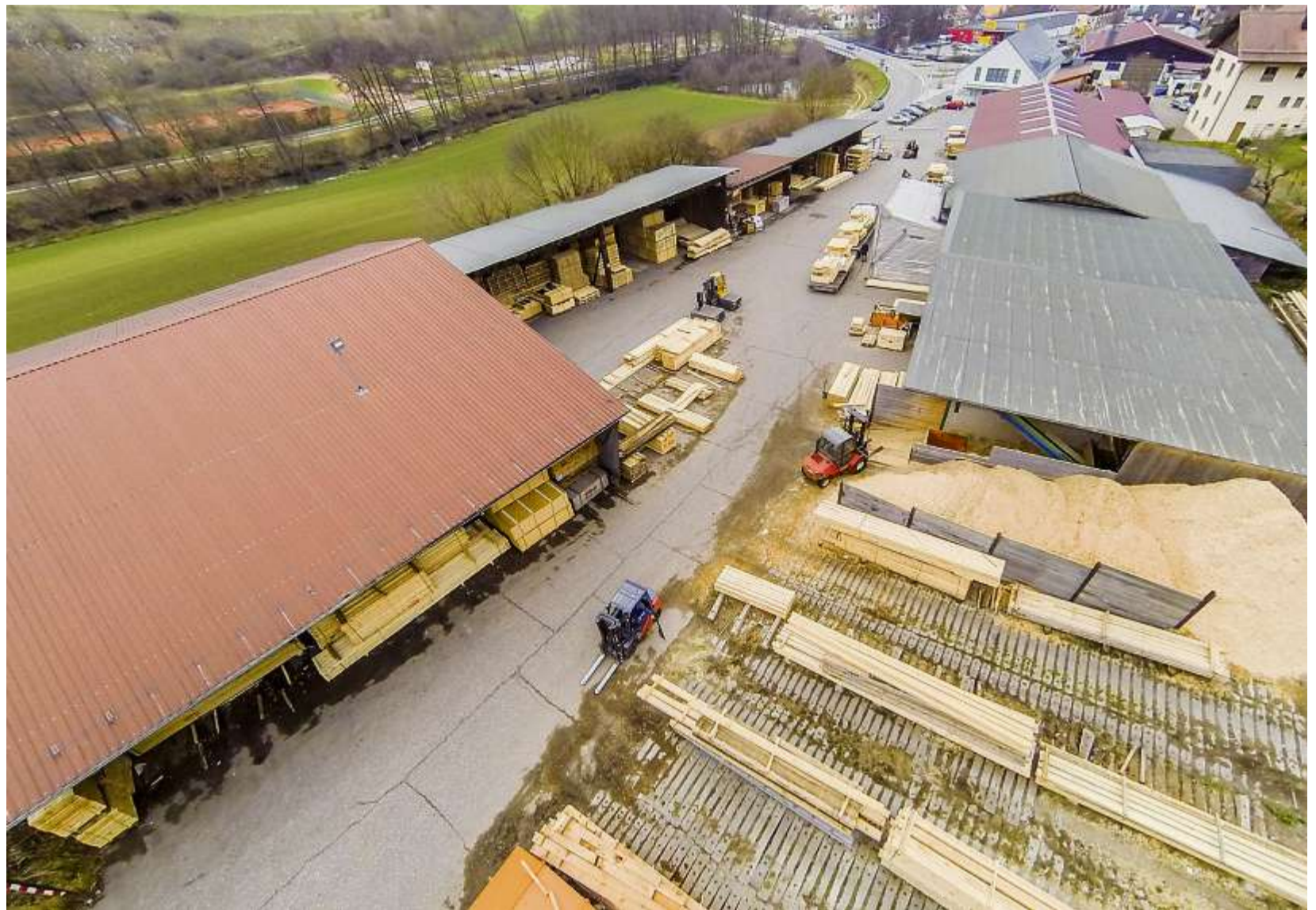
Rund zwei Millionen Euro kosten die neuen Produktionshallen des Unternehmensverbunds Weinzierl, die in Sinzing entstehen sollen. Fotos: Blaschke-Merl
